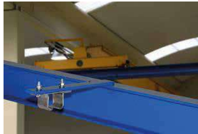
PLETINAS SOLDADAS A LA VIGA
